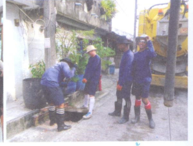
ขุดลอกคูระบายน้ำ
