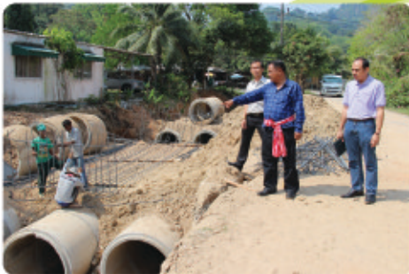
โครงการก่อสร้างวางท่อระบายน้ำพร้อมบ่อพัก และถนน คสล.พื้นที่นาหลวง หมู่ที่ ๓ ตำบลรัชฎา
