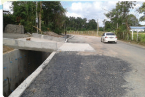
โครงการก่อสร้างวางระบายน้ำ คสล. พร้อมวางท่อระบายน้ำขยายไหล่ทาง ขอยะเนียง หมู่ที่ ๓ ตำบลรัชฎา
